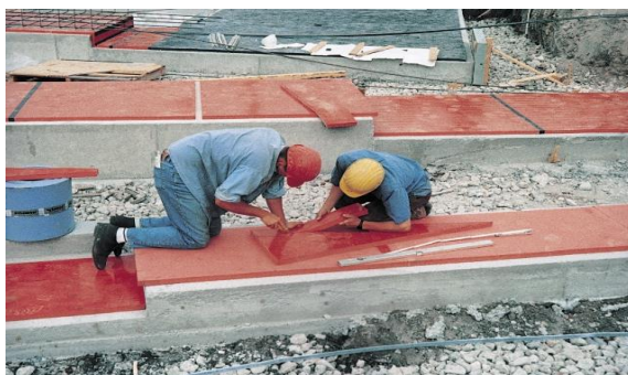
1 – сурет. Құрылыс іргетастарының діріл оқшаулауы
